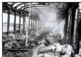
**出火原因:**国鉄京浜線桜木町駅構内の上り線で碍子交換工事を行っていた電気工事作業員が誤ってスパナを落とし、上り線の架線が固定されず垂れ下がってしまっていた。京浜線の赤羽発桜木町行き下り第1271B電車が下り線からポイントを渡って上り線に進入、垂れ下がっていた上り線の架線に先頭車のパンタグラフが絡まり、電流の短絡が発生。激しい火花とともに可燃性の塗料に着火し、車両は木製の屋根から炎上を始めた。
